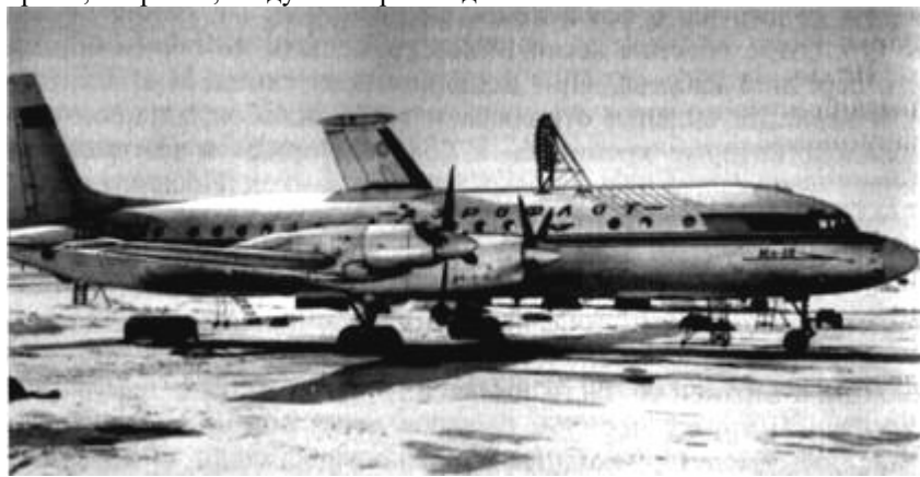
Рис. 69. Летающая лаборатория по отработке противообледенительных систем Ил-18ЛЛ
