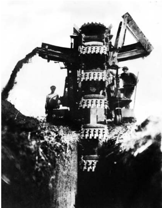
Траншеекопатели стали новинкой трубопроводного строительства, но были большой редкостью (начало 1930-х годов)
