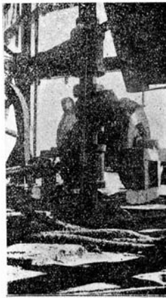
В. Арматура и соединения регулирующего устройства на одной из фонтанирующих скважин в Midway District.
