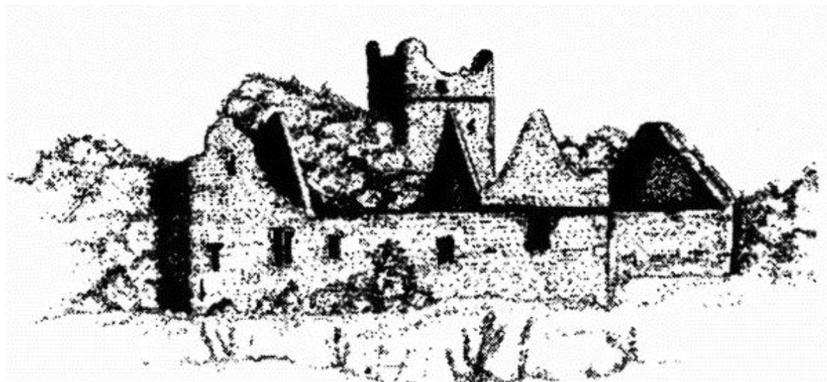
Заброшенное монастырское здание
