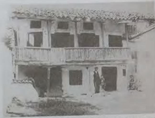
Световые окна, расположенные над входными дверями второго этажа. Фото из журнала Qasevet
