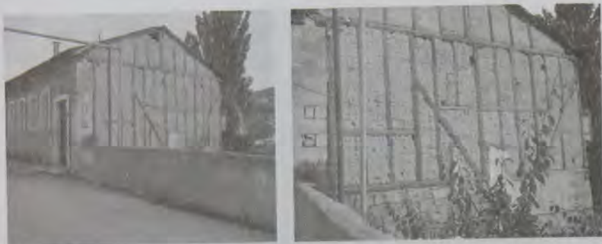
Брусовый дом в Бахчисарае. Отсутствие штукатурки позволяет видеть калыбное заполнение пространств между брусками и массивный каменный цоколь здания. Фото автора
