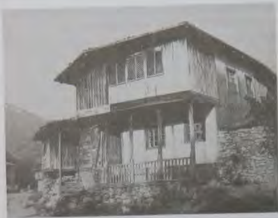
Двухэтажный дом в горной местности. Фото из журнала Qasevet
