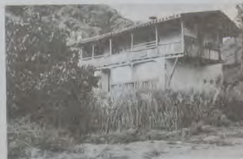
Дом со вторым этажом, опирающимся на консоли. Из: Куфтин, 1925.
