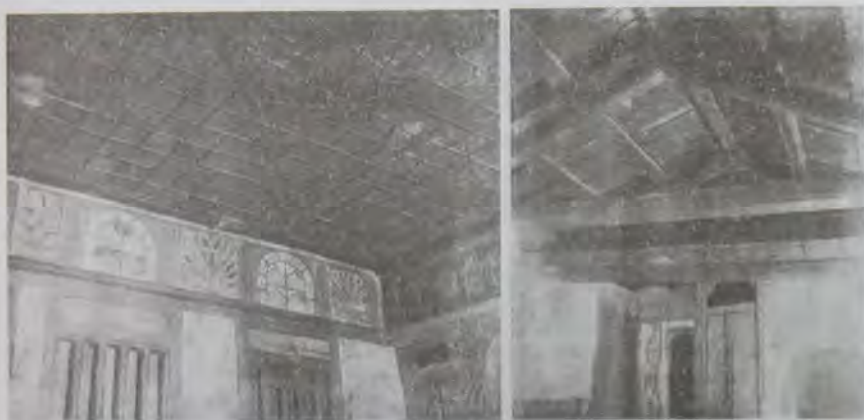
Деревянный потолок с резными украшениями; на предпотолочной полосе стен — изображения окон с цветными стёклами. Из: Куфтин, 1925
