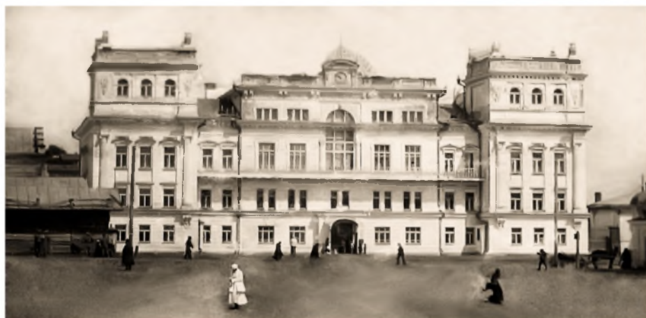
Здание Сарапульского окружного суда. 1913 г. Из фондов МБУК «Музей истории и культуры Среднего Прикамья», Удмуртская Республика, г. Сарапул
