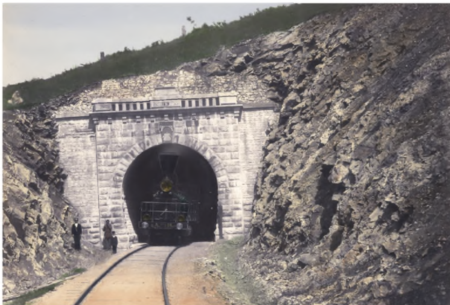
Тоннель на Луньёвской ветке. Конец XIX в.
