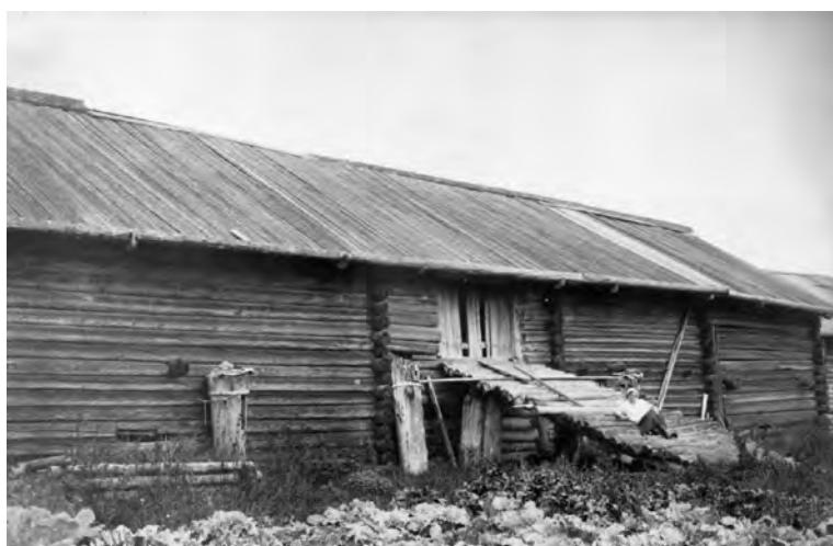
Рис. 66. Двухэтажное хозяйственное строение зажиточного крестьянина. Посередине въезд на второй этаж, по нему завозили запасы кормов на зиму. Из фонда Удмуртского ИИЯЛ УрО РАН. Н.А. Плохинский. 1927
