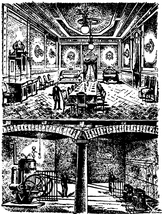
Рис. 6.12. «Блок-станция» — электростанция с двумя генераторами (внизу справа) и локомотивом (слева) для освещения одного дома
