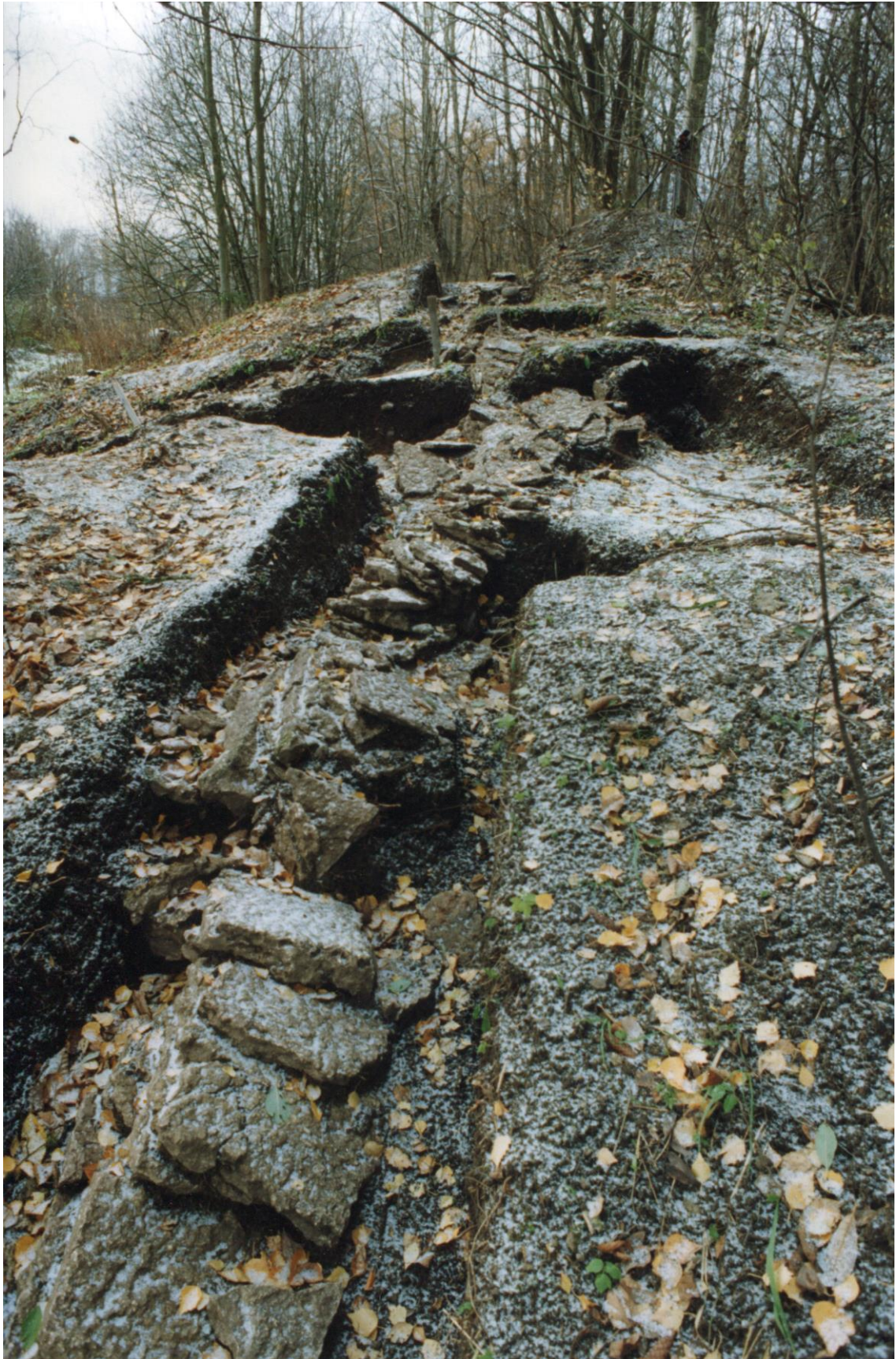
Гребень подпорной стены с напольной стороны крепости
