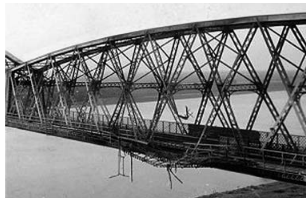
Повреждённый атакой СПБ Чернаводский мост через Дунай
