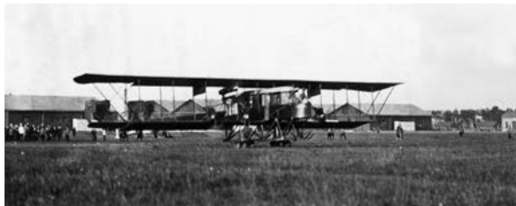
Взлёт «Русского витязя» с четырьмя расположенными в ряд моторами. Эта схема стала классической для тяжёлых самолётов
