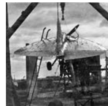
Исследование обтекания «Стрелы» на наземном стенде. Апрель 1938 г.
