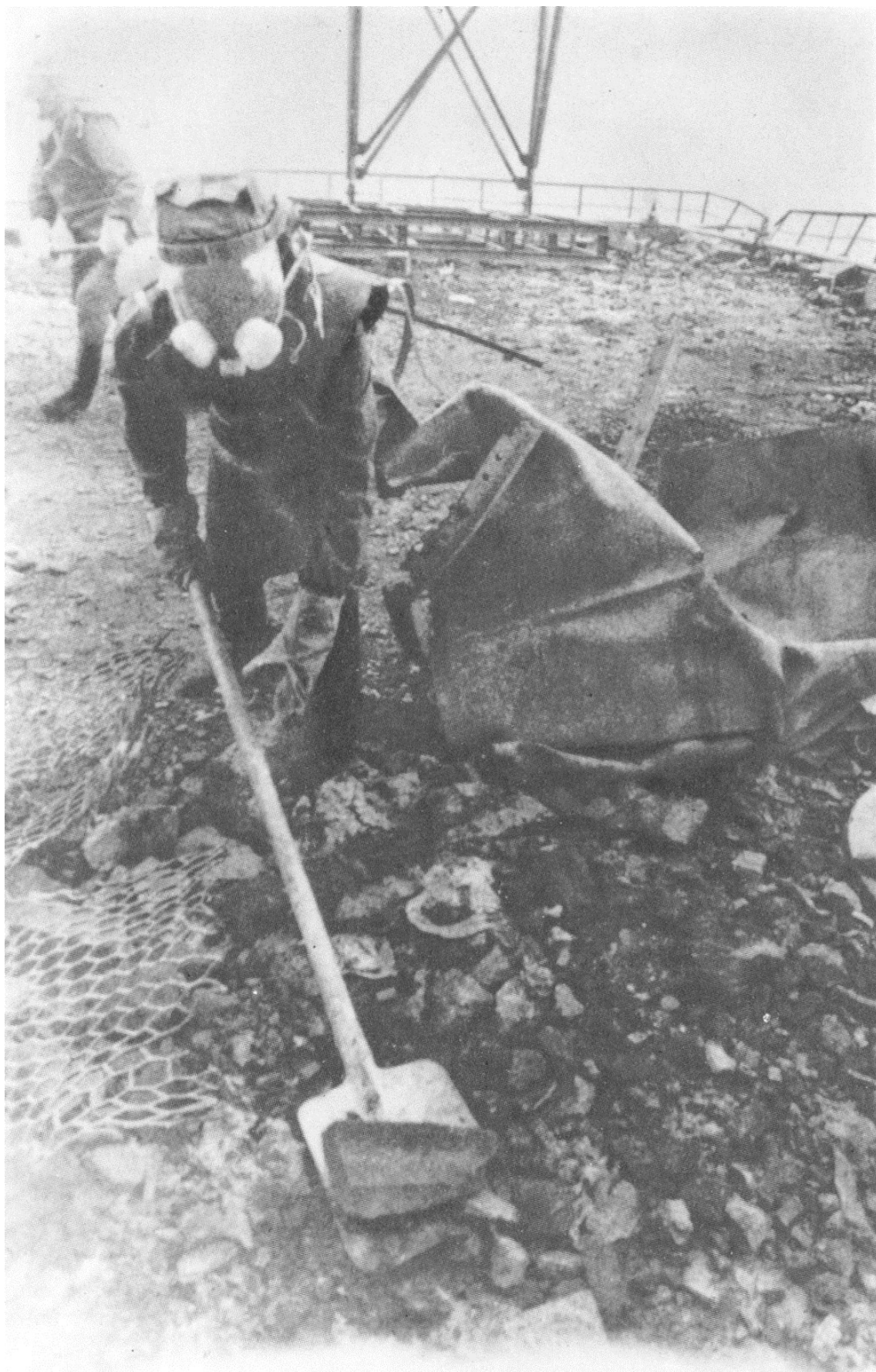
Удаление высокорadioактивных элементов с крыш третьего энергоблока АЭС
