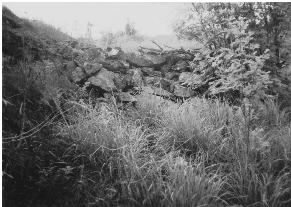
Рис. 105. Городище Линнасаари в заливе Токкарлахти. Вал в восточной части. Вид с СЗ
