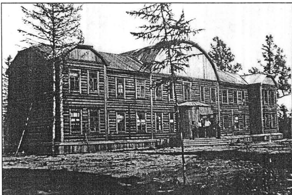
Здание КРУ ДС на берегу Колымы (30-е гг.)
