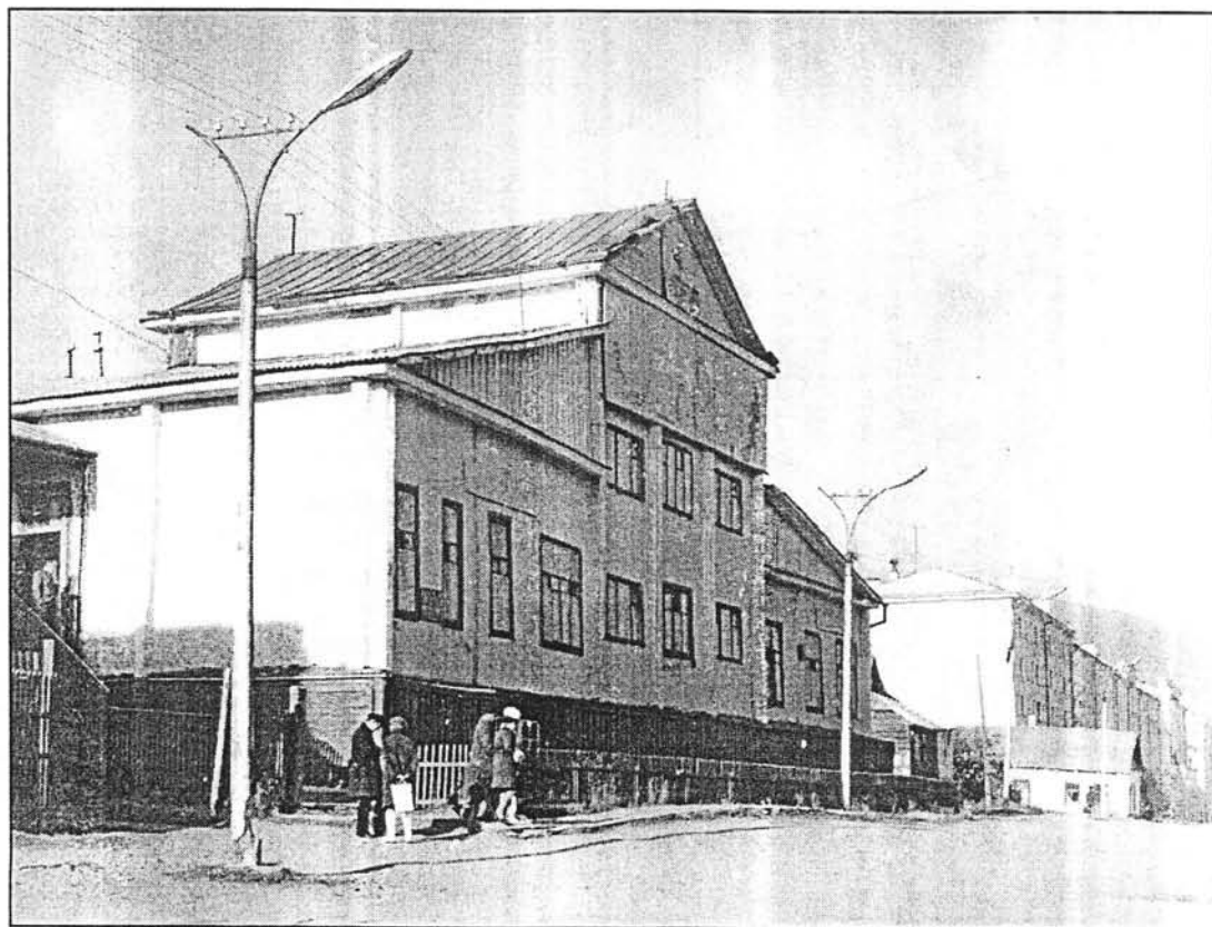
Здание Магаданского драматического театра постройки 30-х гг.
