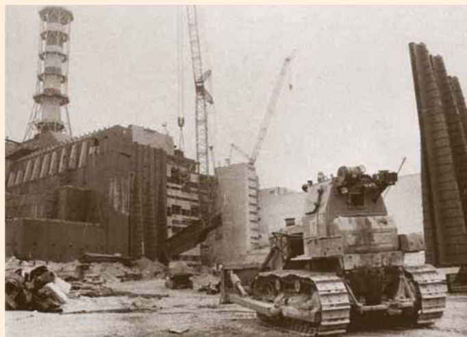
Фрагмент монтажа контрфорсной стены. В течение 20 дней стена была смонтирована и забетонирована
