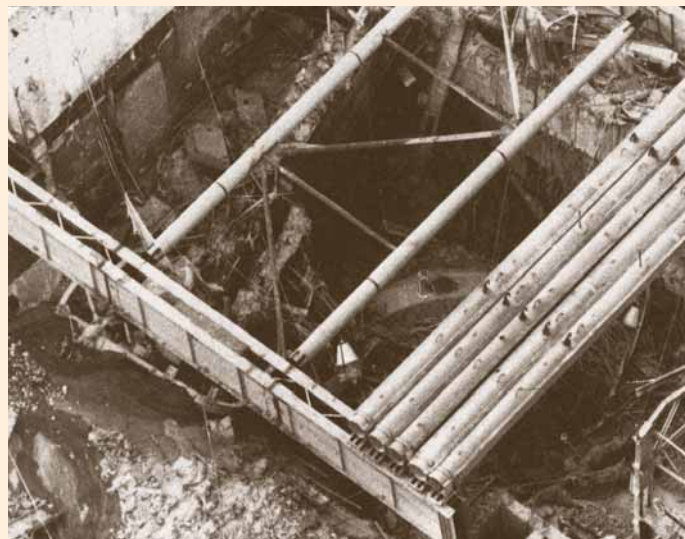
Монтаж труб перекрытия проводился по конструкции балок «Самолет». Внизу видна крышка реактора «Е»
