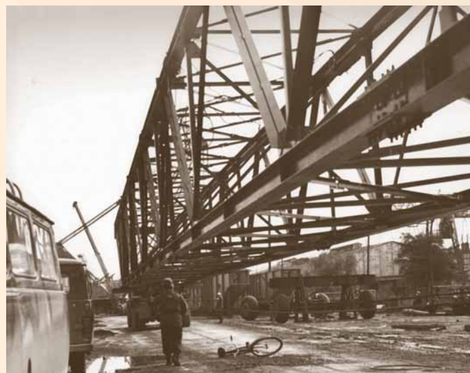
Доставка металлоконструкции к Саркофагу
