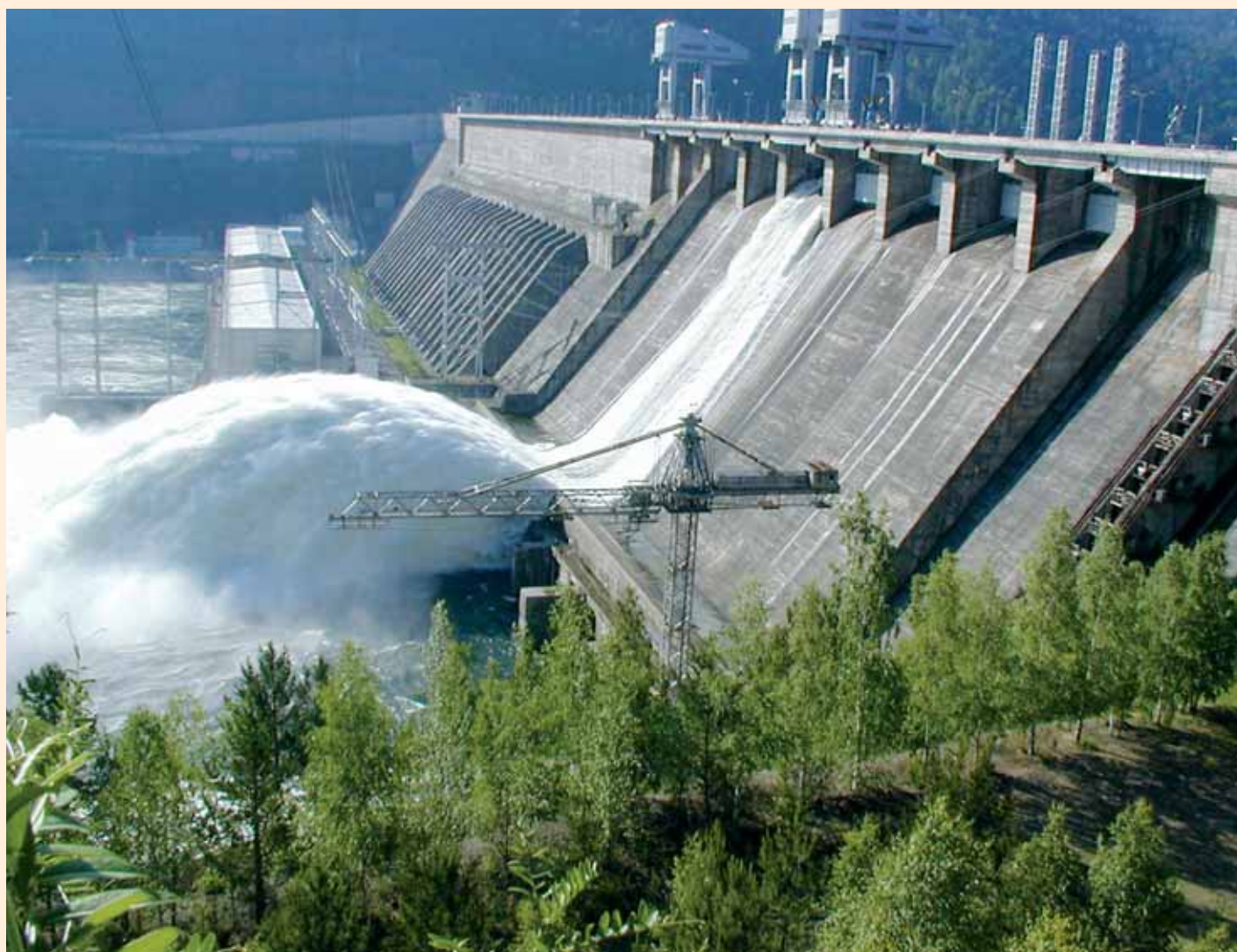
Красноярская ГЭС входит в десятку крупнейших гидроэлектростанций мира
