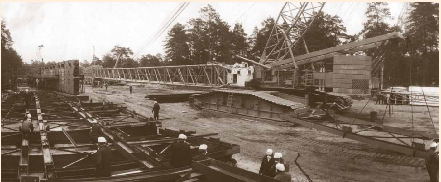
Площадка для сборки кранов DEMAG
