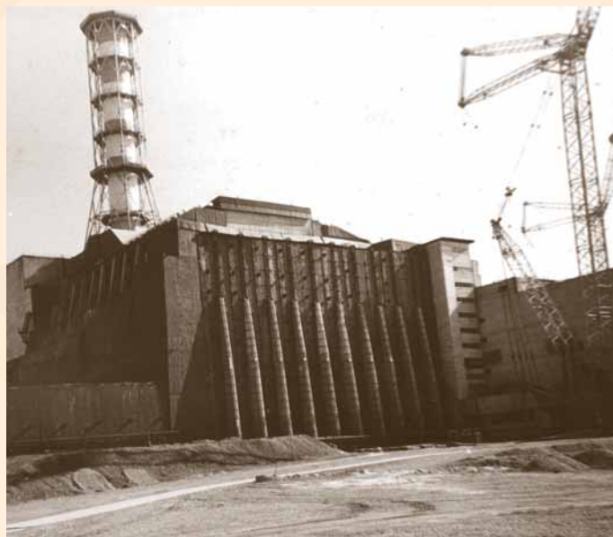
Разрушенный взрывом энергоблок ЧАЭС был надежно укрыт Саркофагом
