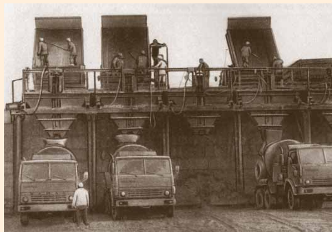
Узел перегрузки бетона позволил уберечь от радиоактивного загрязнения большое количество автотранспорта
