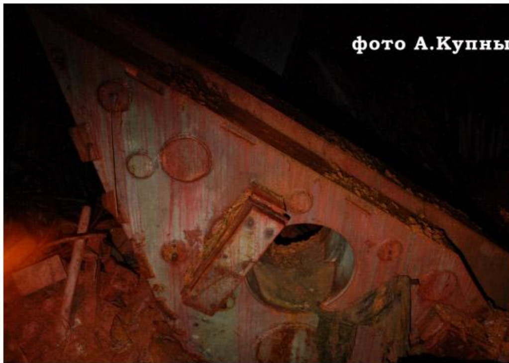
Крышка биологической защиты реактора «Елена», перевернутая взрывом в апреле 1986 г. С тех пор ее положение не изменилось. Вид изнутри реактора. 2009 г.
