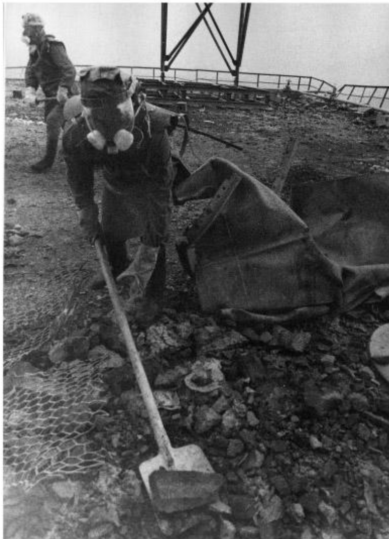
Дезактивация кровли машинного зала 3-го ЭБ Чернобыльской АЭС
