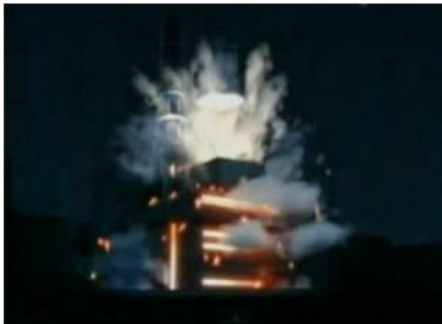
Взрыв реактора 4-го энергоблока. Вверху видна взлетевшая крышка биологической защиты «Е» «Елена». Компьютерная версия взрыва 4-го блока
