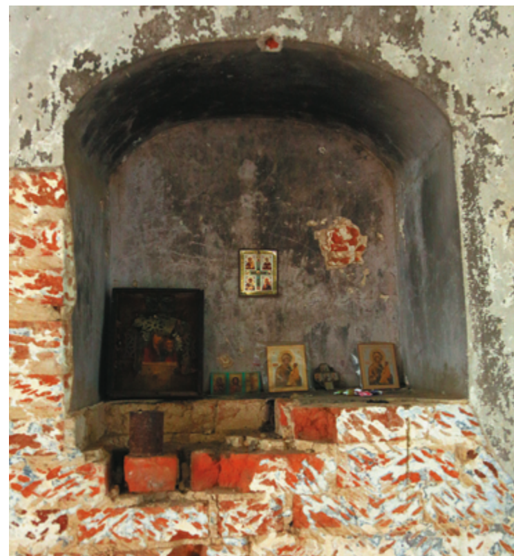
Алтарь в недействующей церкви. Фото 2017 г
