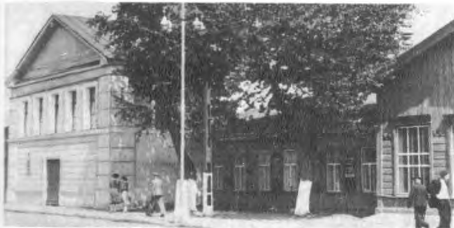
Здание клуба железнодорожников, где в 1905 году помещался стачечный комитет, руководивший октябрьской политической забастовкой
