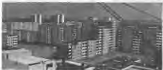
Строительство микрорайона Восток-3. 1983.
