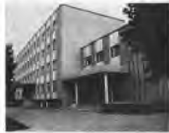
Ремонтно-строительный трест «Стройбытремонт».
