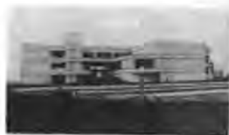
Здание Московского РК КПБ.
