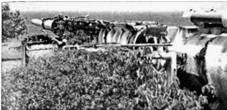
406-миллиметровая пушка проекта «HARP» (снимок с острова Барбадос)
