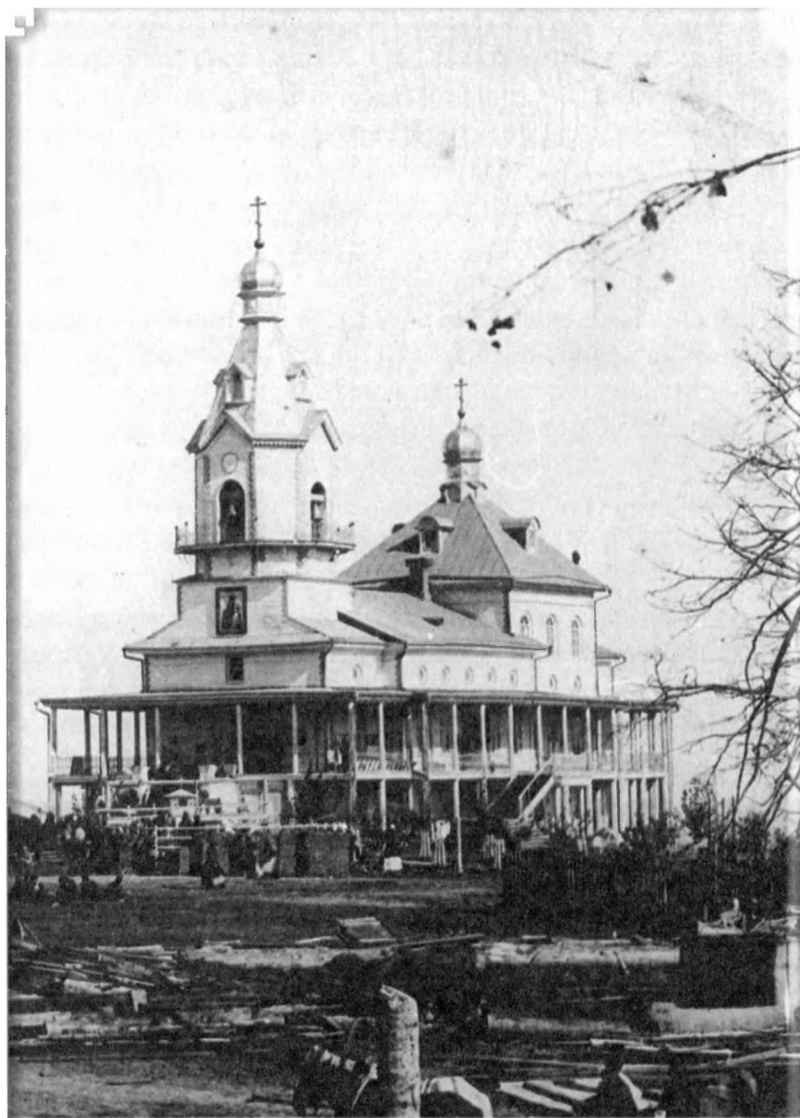
Строительство храма Иверской иконы Божией Матери
