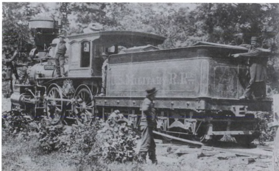
Локомотив военно-железнодорожной службы; члены паровозной бригады указывают места попадания снарядов мятежников U.S. Army Military History Institute
