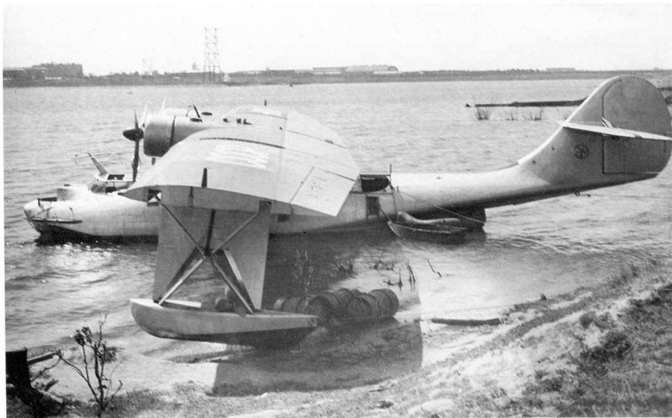
И243 после демонтажа колпака носовой турели
