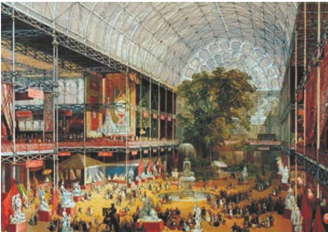
*Модульная структура Хрустального дворца, вдохновленная растением, позволила обойтись без традиционных колонн и несущих стен и сделать функциональным все внутреннее пространство.*
