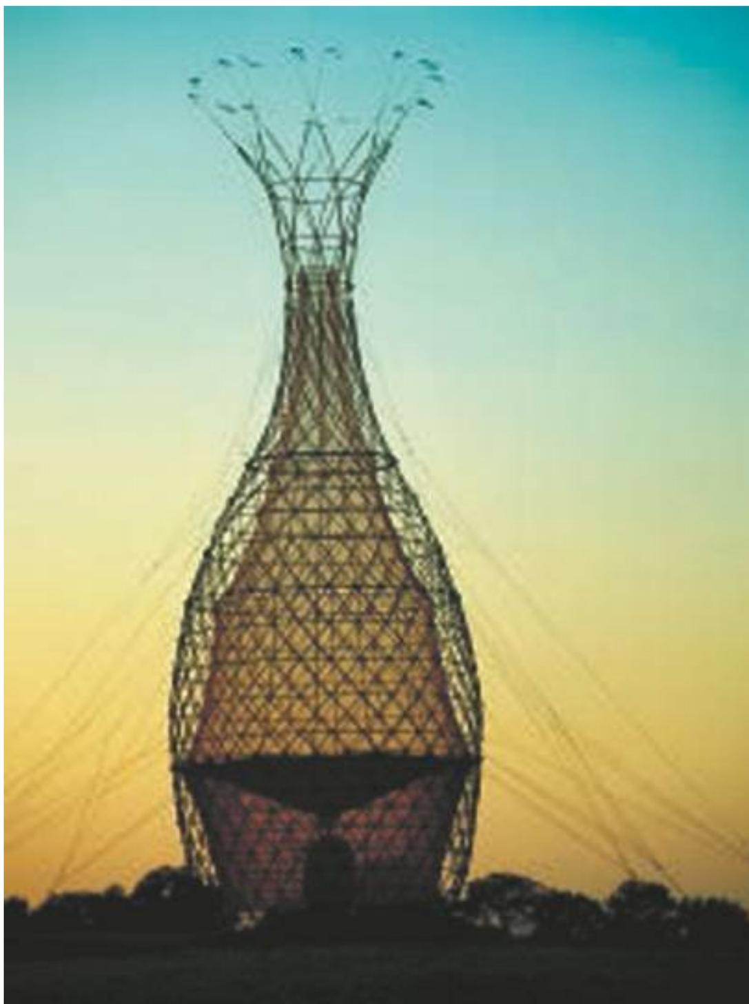
*Изображение башины Warka Water, спроектированной Артуро Виттори. Это строение способно получать воду из атмосферы путем конденсации.*
