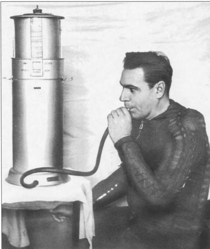
И. П. Неумывакин проверяет жизненную емкость легких с помощью водяного спирометра в высотном-компенсирующем костюме, 1960 г.
