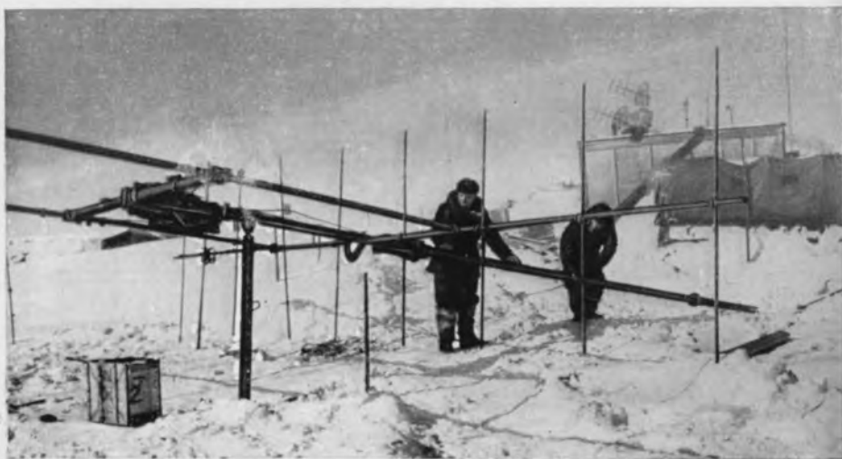
Сборка антенны радиолокатора
