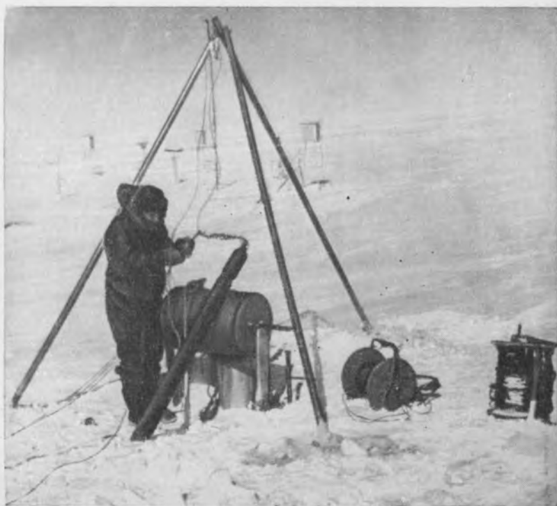
Подготовка к термическому бурению
