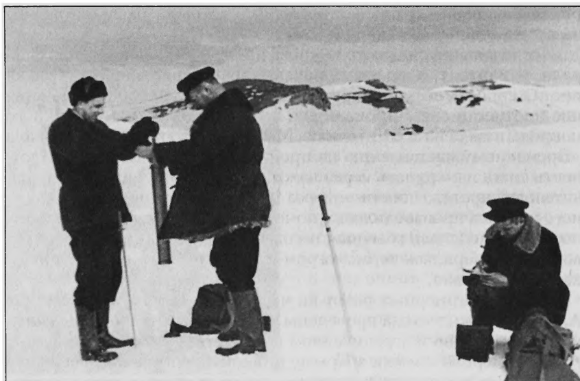
Измерение плотности снежного покрова на Караби-яйле
