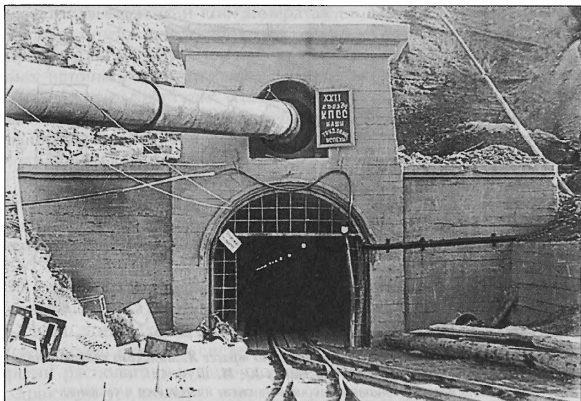
Строительство северного портала Ялтинского гидротоннеля
