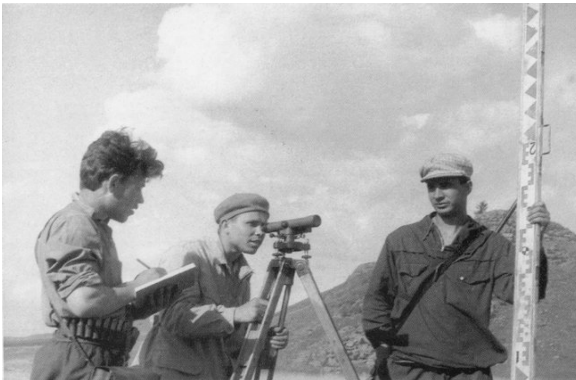
Прокладывают нивелирный ход
