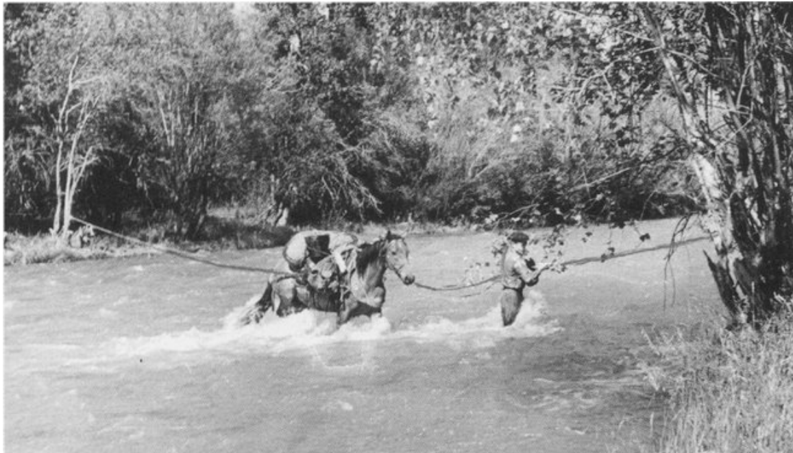
Переправа через горную реку
