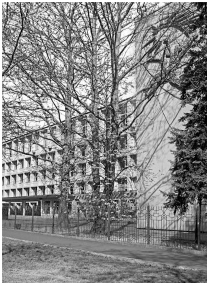
Политехнический институт – Главный корпус
