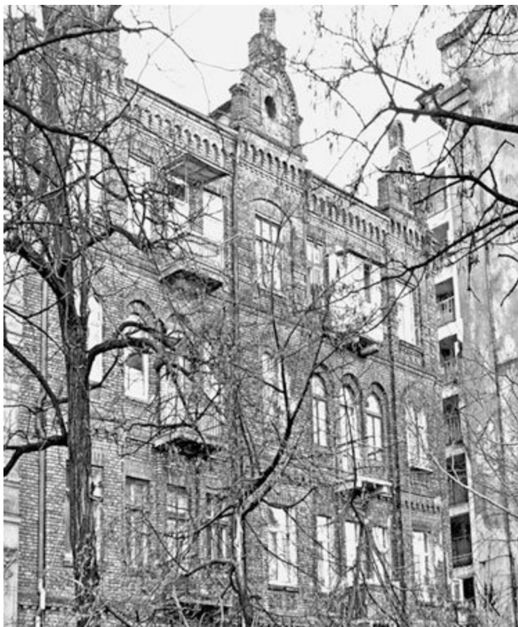
Кирпичный дом и тылы книгохранилища в переулке Ляпунова
