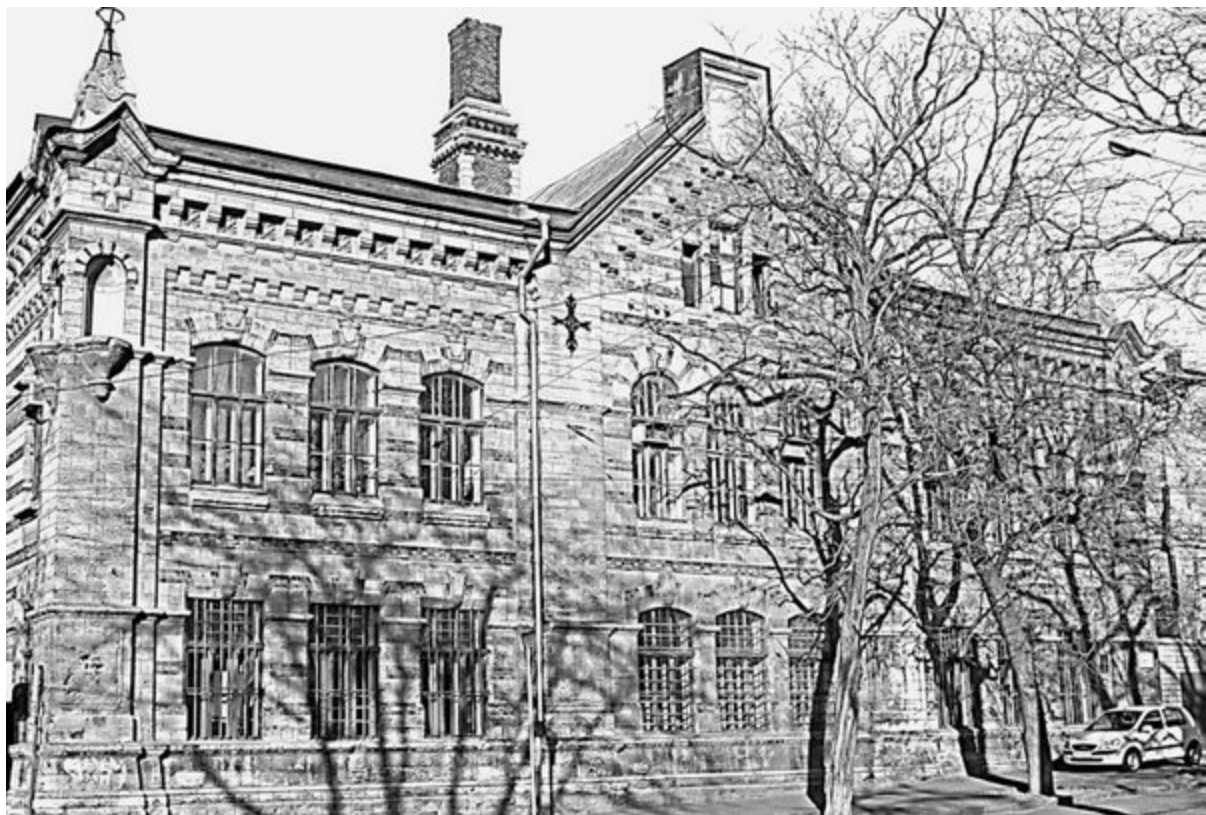
Здание школы десятников строительного дела
