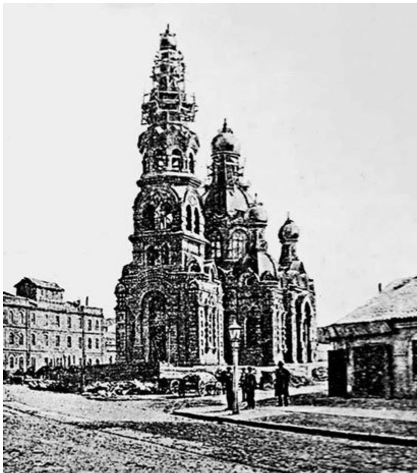
Строительство Мещанской церкви
