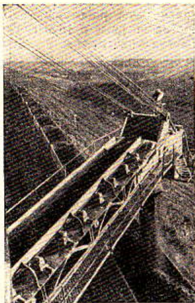
Камышбурунский железорудный комбинат. Многоковшовый экскаватор за погрузкой железной руды.
