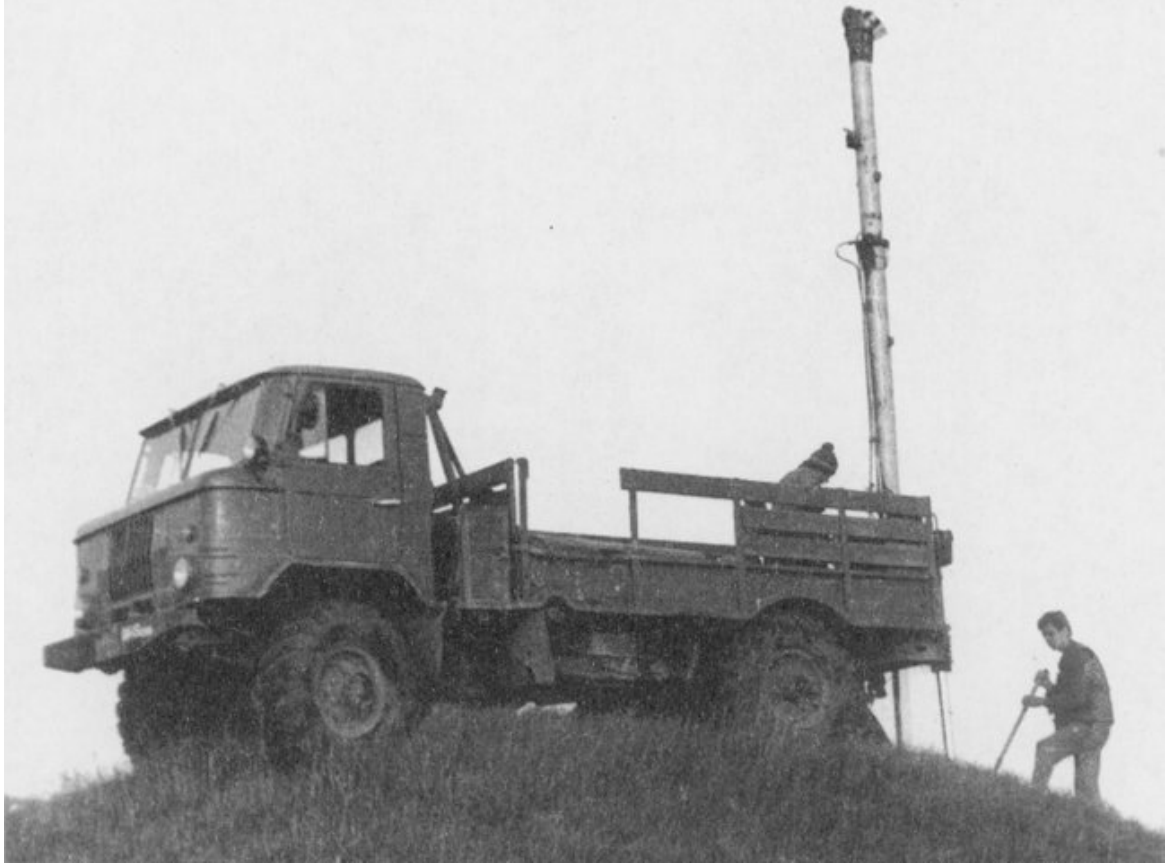
Закладка реперов методом бурения
