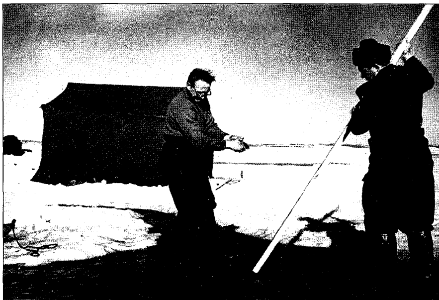
Арктическим летом, когда поверхность льда интенсивно тает, необходимо регулярно прочищать лунки для стока талой воды в океан (СП-13) (фото из архива Ю. П. Доронина).
