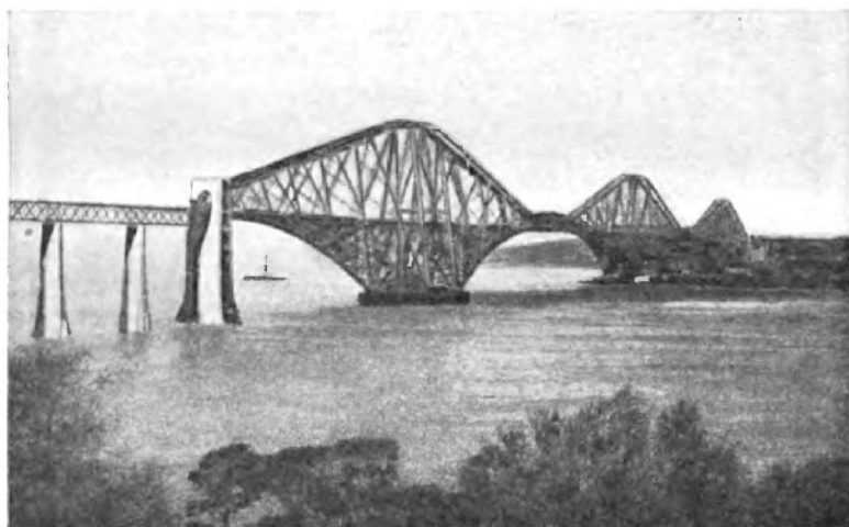
Форснѣй мостъ; видъ съ юго-восточной стороны.
