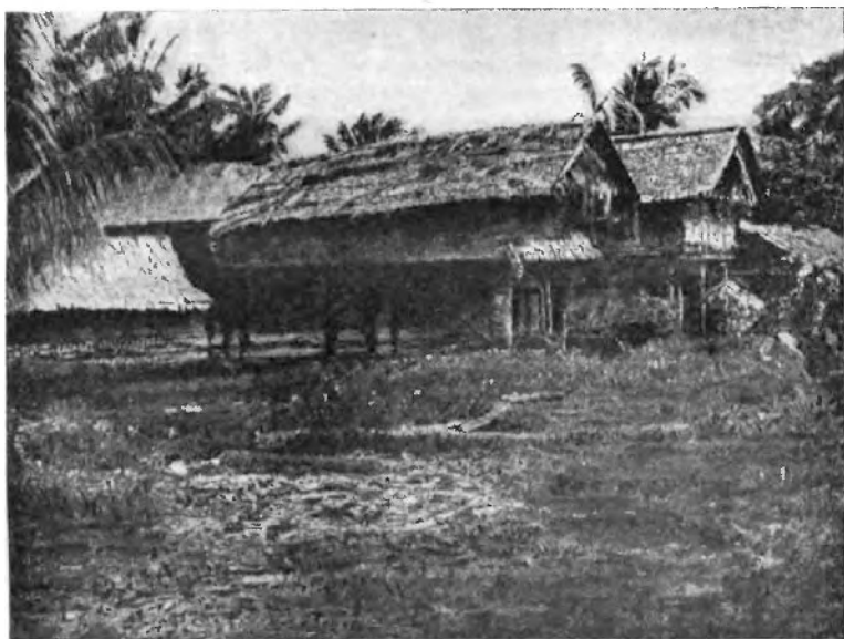
Д ма на сваяхъ; островъ Фауро (архипелагъ Соломоновыхъ острововъ).
