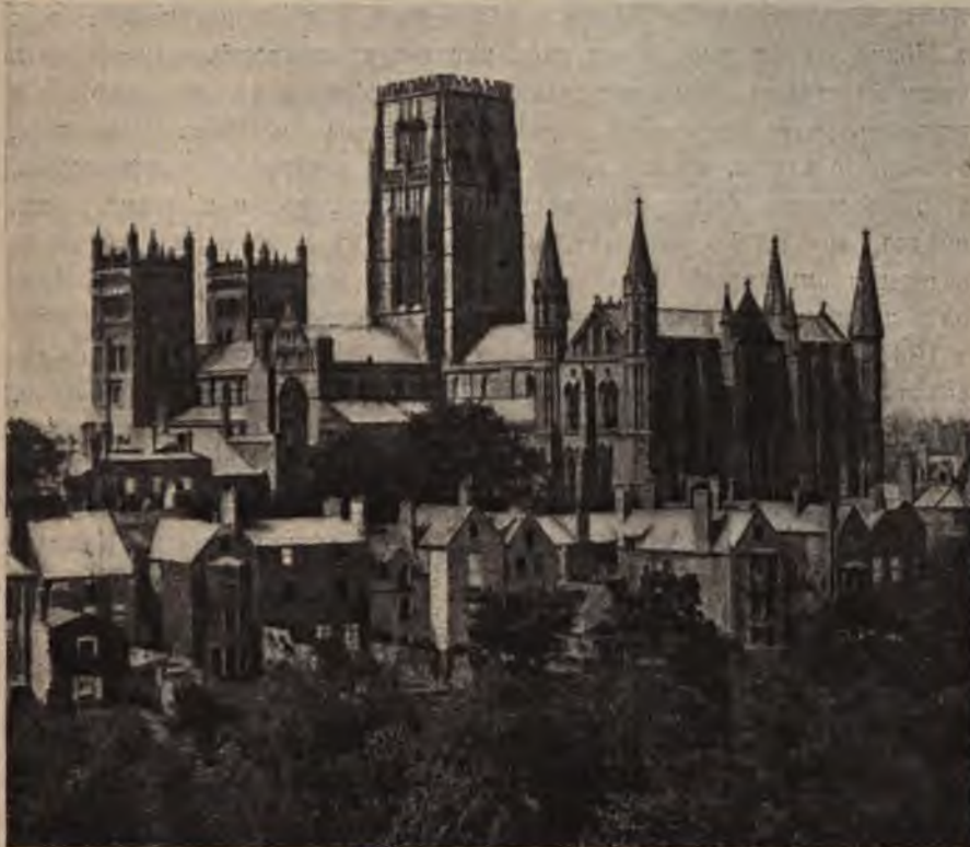
Соборъ въ Дургемѣ, построенный между 1093 и 1135 годами.
