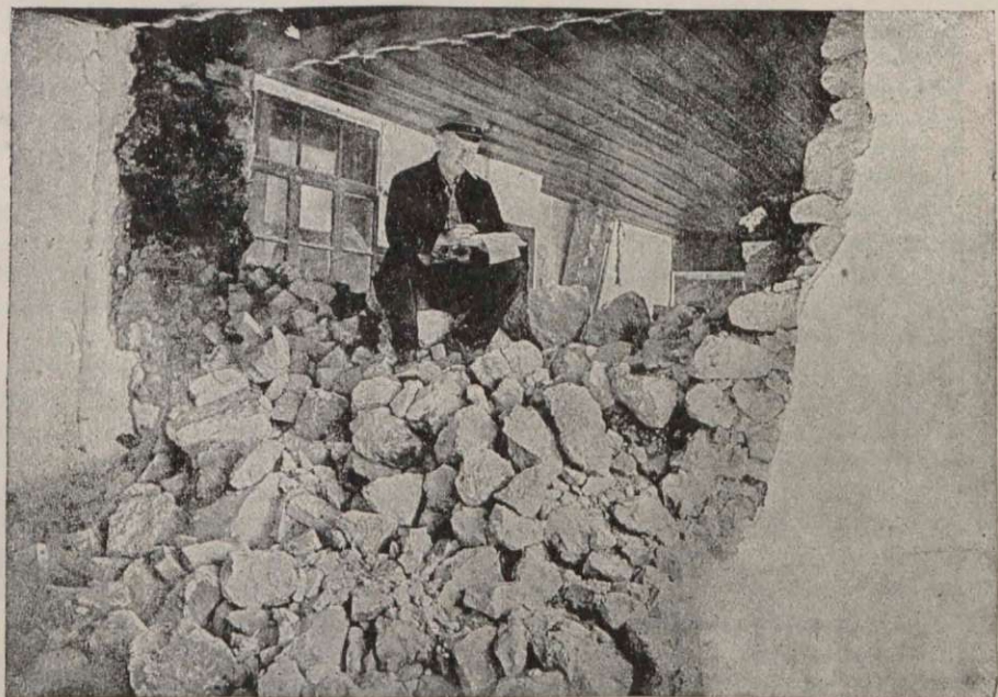
Дер. Кекенеиз. Здание сельсовета у шоссе. Выпадение зап. толстой внутренней стены из бутовой кладки на глине
