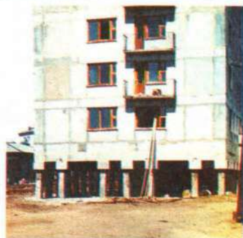
Такие дома на свайных фундаментах не нарушают температуру вечной мерзлоты, что и сохраняет их устойчивость во время эксплуатации.
