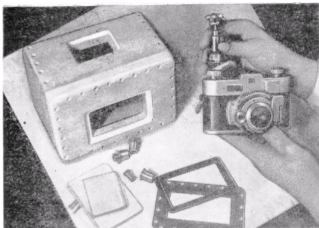
Рис. 23А. Неокрашенный деревянный бокс с гнездом для стекол окон. Справа над заводной головкой аппарата показана рукоятка управления переводом пленки, сочленяющаяся с заводной головкой. Перед боксом рядом со стеклами и пластинами для крепления стекол окон видны сальники для остальных органов управления
