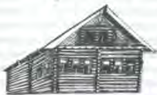
Традиционное жилище коми 1 — дом с окном над полатами (с. Подчерье); 2 — дом, имею- щий двухэтажную зимнюю и летнюю избы (с. Ижма); 3 — дом с мезонином (с. Лойма)
