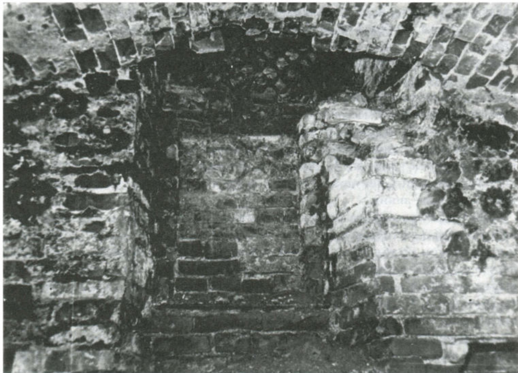
Закладка выхода в подземный ход из подвалов Демидовского дома в г. Невьянске
