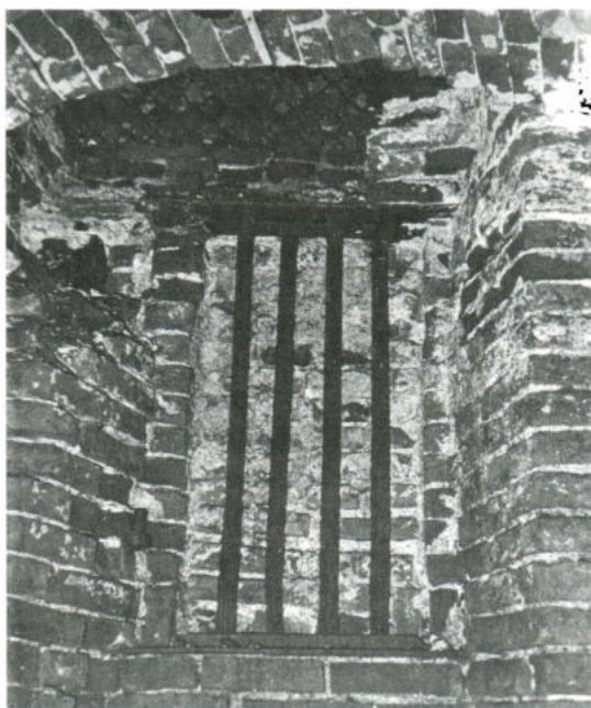
Закладка проема в подвале Демидовского дома в г. Невьянске
