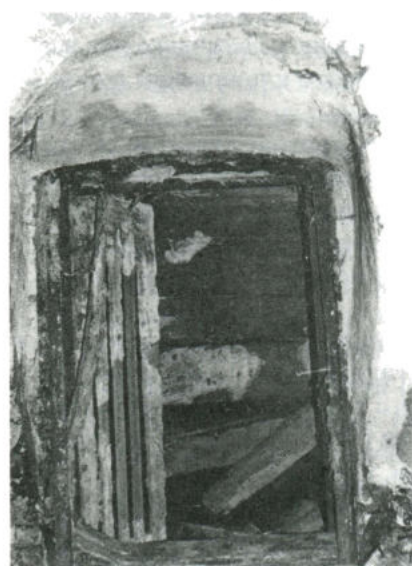
Подземелье заводской конторы
