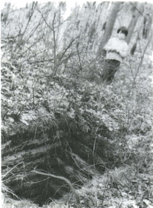
Глубоченский тоннель. Смотровой колодец
