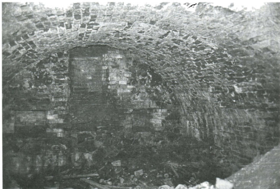
Подвал Демидовского дома в г. Невьянске
