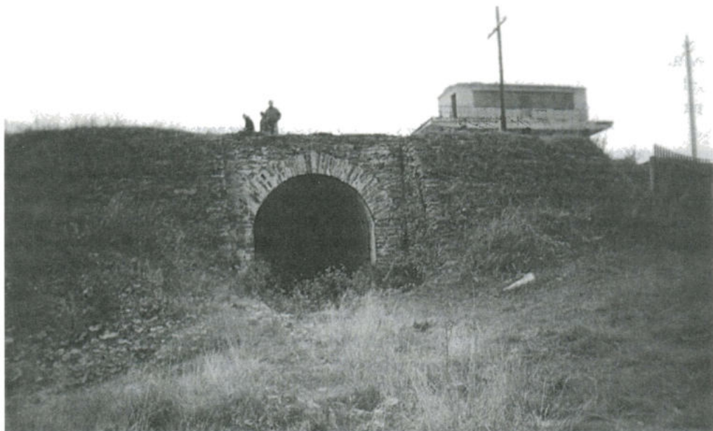
Тоннель в плотине
