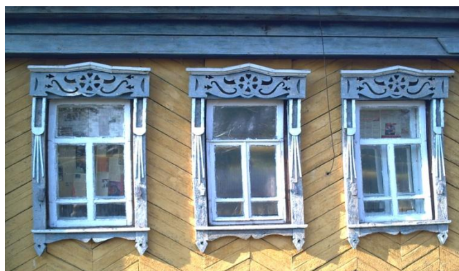
Пропильная резьба на наличниках. с. Ср.Тимерсяны, Цильнинский район.
