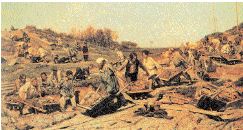
К. Савицкий. Ремонтные работы на железной дороге
