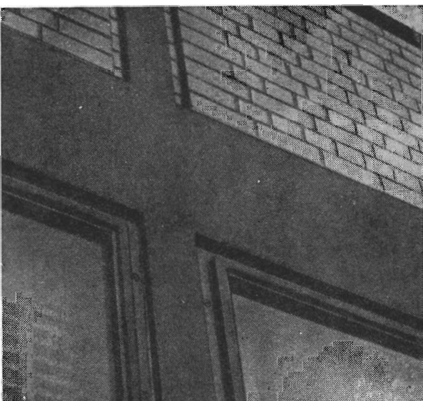
Вид оконных рам и кирпичной кладки
