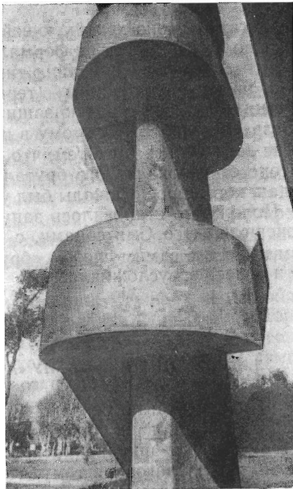
Наружная пожарная лестница.
