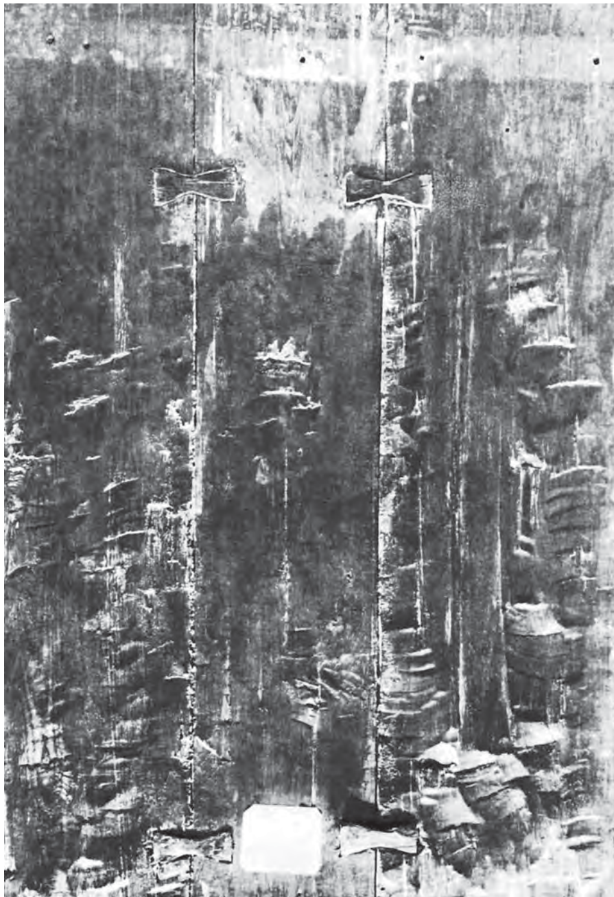
Ил. 1. Следы обработки топором (зарубки)
