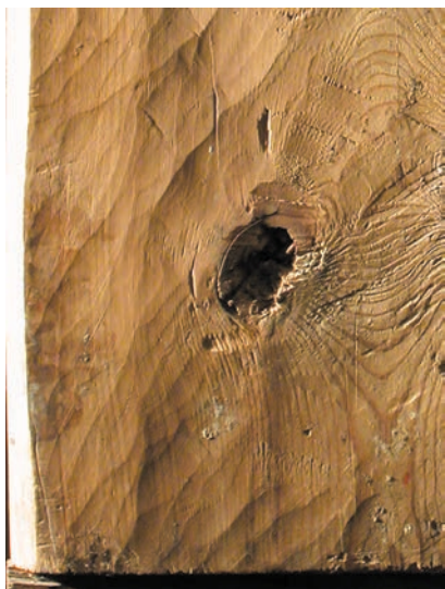
Ил. 1а Следы обработки скобелем
