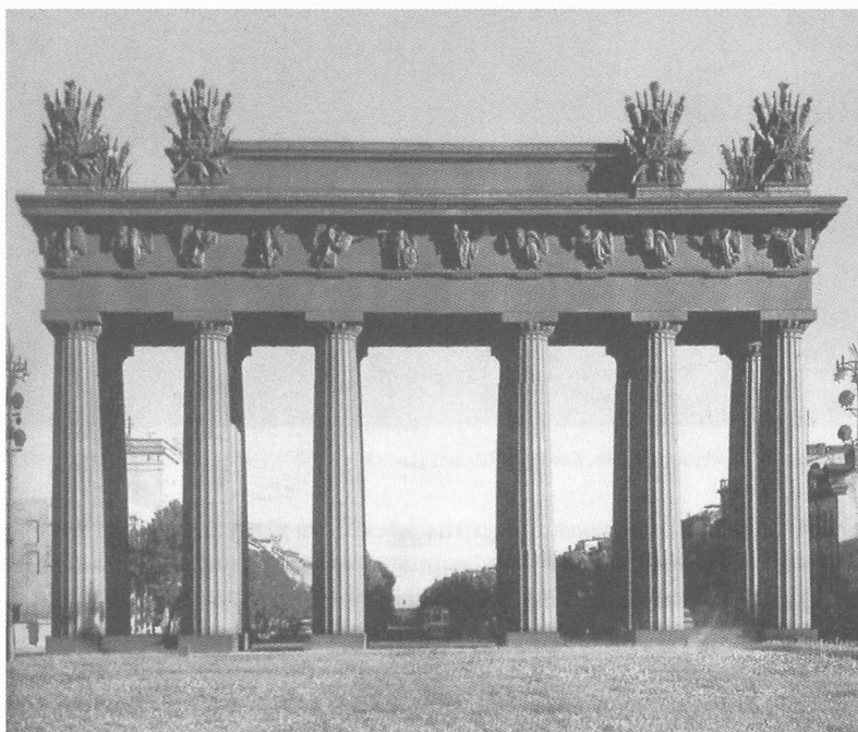
К. Росси. Здание Сената и Синода на Сенатской площади в Санкт-Петербурге. 1829—1834 В. Стасов. Московские триумфальные ворота в Санкт-Петербурге. 1834—1838
