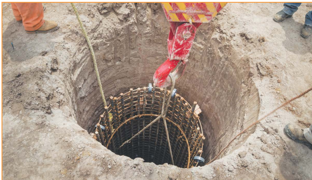
Устройство свай способом заливки
