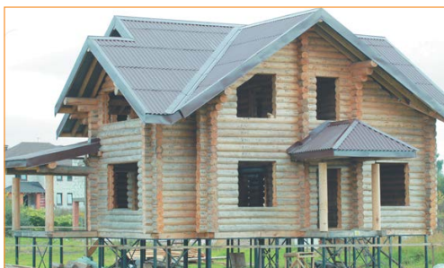
Сруб на металлических трубах
