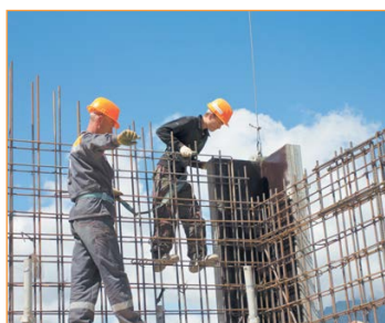
Обеспечение связи фундамента с монолитными стенами
