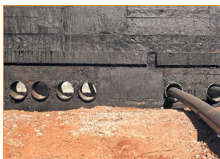
Гидроизоляция фундамента окраской
