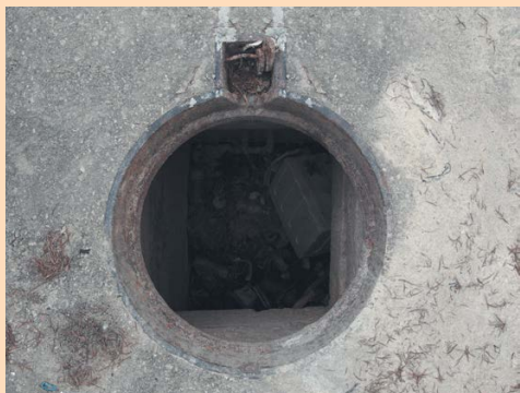
Технологическое отверстие, устроенное на этапе установки опалубки
