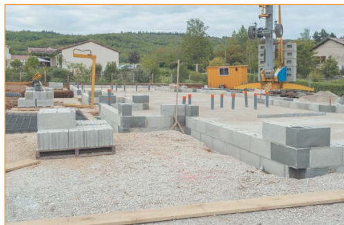
Устройство блочного фундамента механизированным способом
