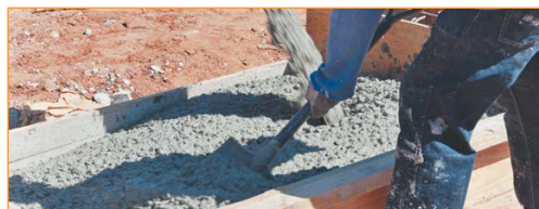
Уплотнение бетонной смеси штыкованием
