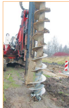
Ввинчивание свай для будущего фундамента
