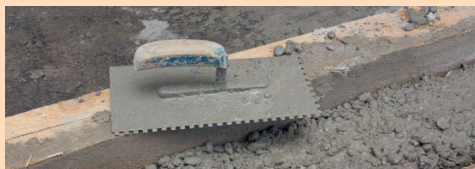
Выравнивание горизонтали бетонной смеси по кромке доски
