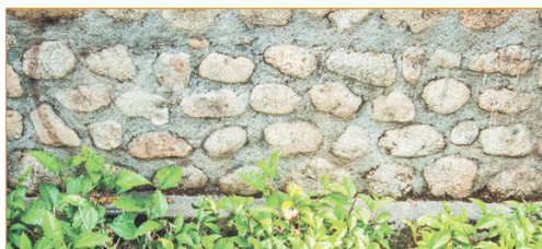
В итоге фундамент будет иметь вид стены в средневековом стиле
