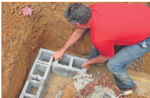
Устройство блочного фундамента кладочным способом вручную
