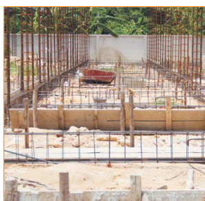
Обеспечение связи фундамента с колоннами
