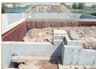
Гидроизоляция фундамента накладкой
