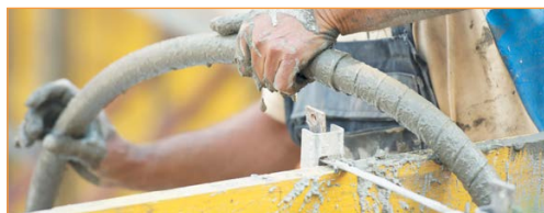
Уплотнение бетонной смеси вибрированием
