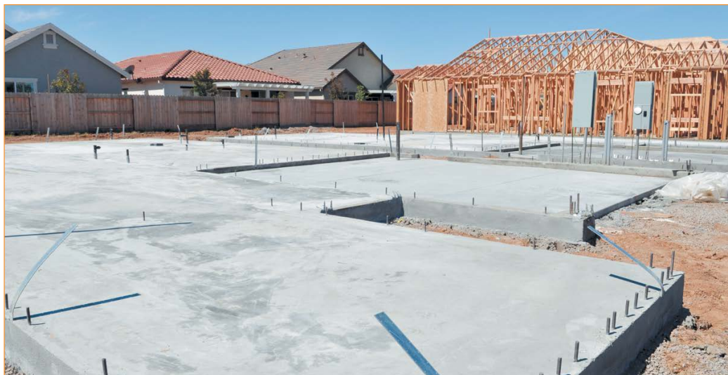
Монолитный плитный фундамент
