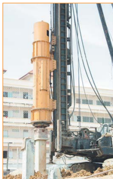
Забивание готовых свай
