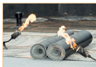
Гидроизоляция фундамента оклейкой
