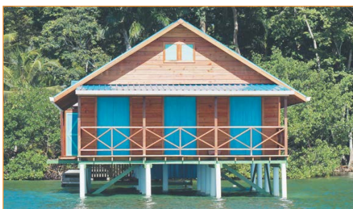
Устройство свайного фундамента для постройки дома над водой
