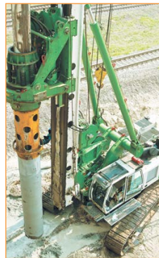
Устройство свай вибрированием
