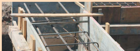
Выравнивание бетонной заливки по бечевке
