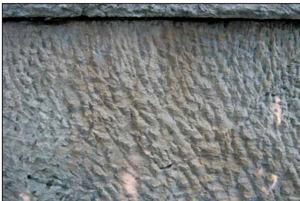
Фото 94. «Получистая теска». Четко сформирована плоскость. Видны следы плоского инструмента типа закольника.
