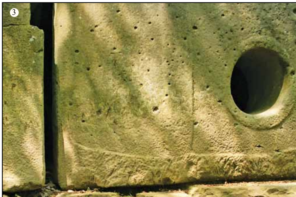
Фото 121-3. Элемент рельефа заканчивается у необработанной нижней части портала, на которой видны следы грубого, первоначального выравнивания.
