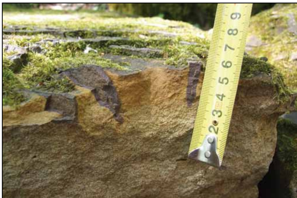
Фото 167. Скол порталной плиты. Хорошо видно, как ребра решетки, проникая в глубь песчаника на 2—3 см, постепенно сужаются.
