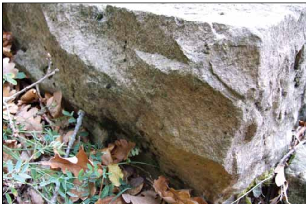
Фото 93. «Грубая теска». Откалывались куски камня размером до 20 см. Текстура «рваного» камня или «скалы». Следов инструмента не видно.
