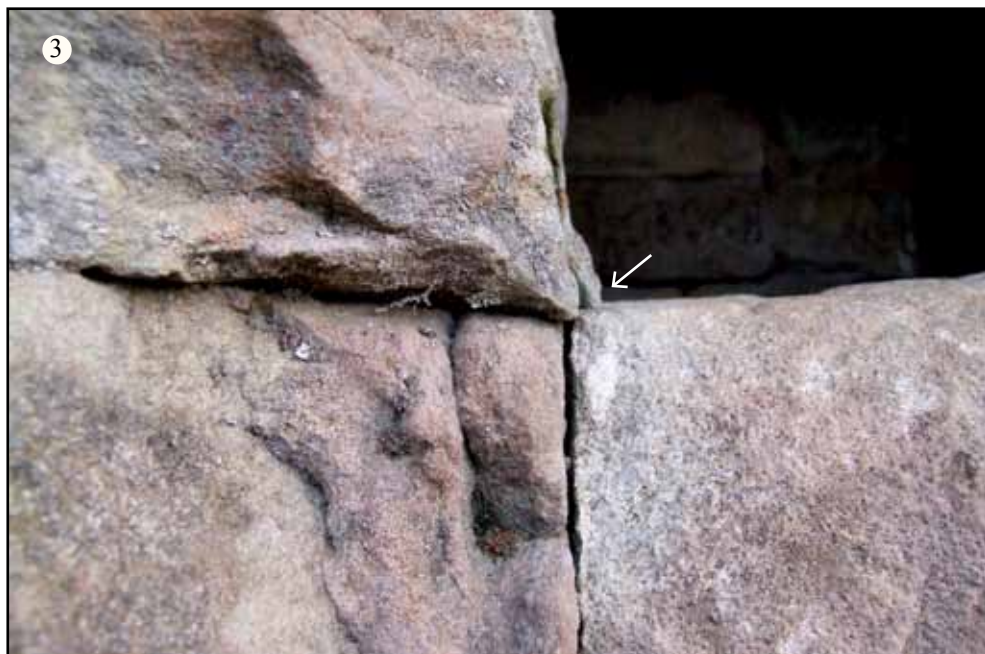
Фото 109-3. Стыковка трех блоков. Справа — блок порталъной плиты. Слева внизу — блок левой стенки, нижний ряд. Вверху слева — стеновой блок среднего ряда.
