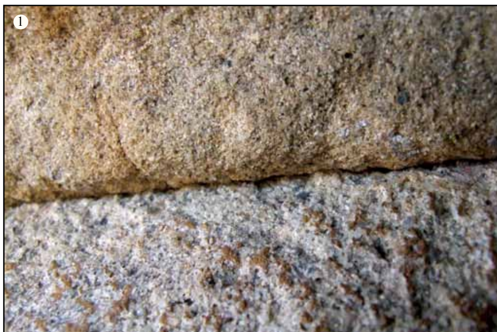
Фото 106-1. Идеальное сопряжение покровной плиты с порталной. Зазор полностью отсутствует, совпадают мельчайшие выступы.
