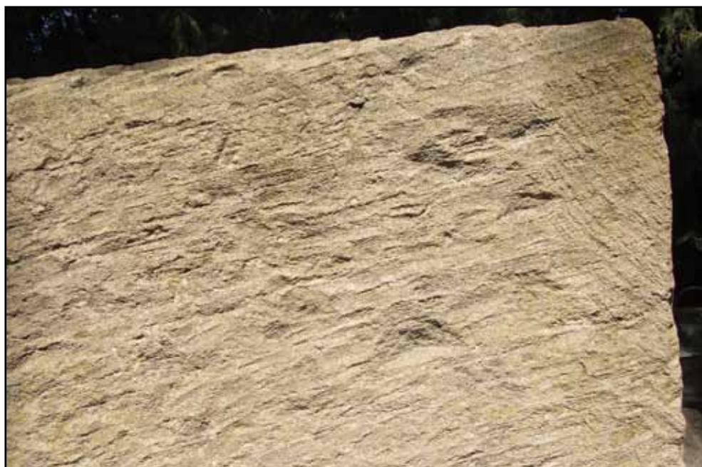
Фото 95. «Чистая теска» — отделка камня инструментом типа скапеля: удары наносились почти перпендикулярно отделяемой поверхности (ковка камня).
