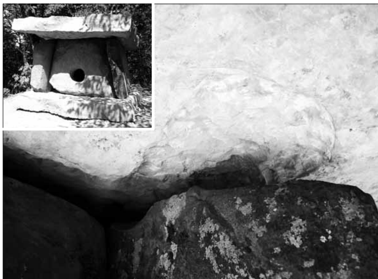
Фото 16. Дольмен 2007 года. Район Геленджика. Крупно представлены верхний правый угол порталной плиты, покровная плита и боковая. На фотографии видно, как не совпадает паз в покровной плите с торцом боковой и порталной плит. И такие несовпадения по всем стыкам. Сравните качество стыков на фото 17.
