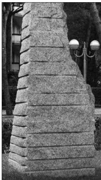
Фото 7. Следы от просверленных шпуров, в которые забивали металлические клинья для откалывания.
