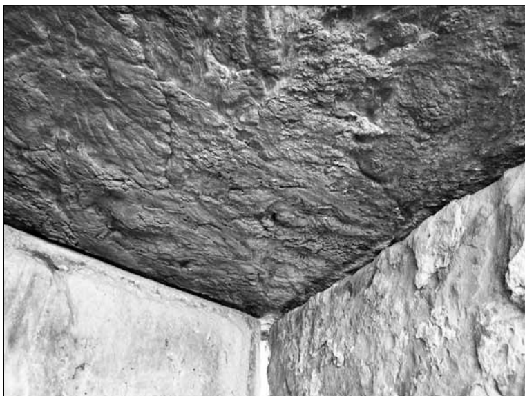
Фото 24. На нижней части покровной плиты в большинстве дольменов видны следы натеков (за исключением тех дольменов, где потолок в камере стесан) и посадочные выемки, в точности соответствующие граням верхних торцов плит.
