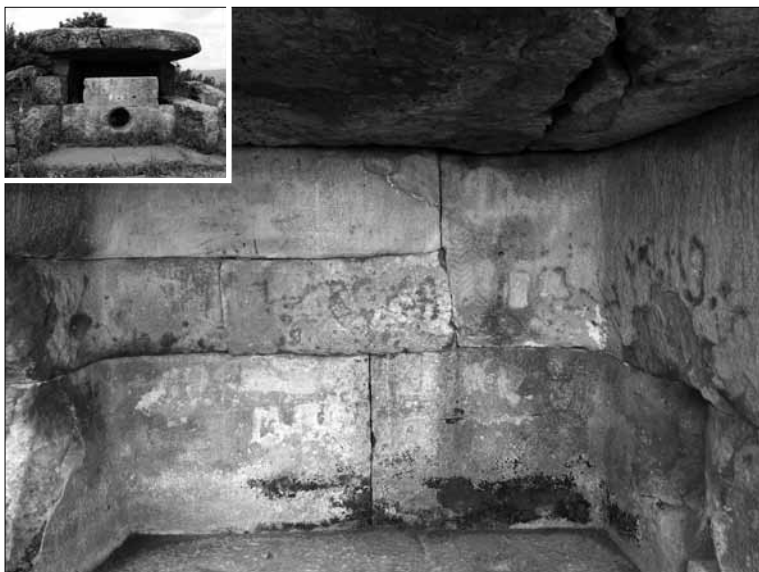
Фото 14. Задняя и боковые стенки составного дольмена на горе Нэксис. Боковые блоки имеют Г-образную форму и переходят с боковых стен на заднюю. На задней стенке блоки стыкуются по криволинейным линиям. Покровная плита без зазоров примыкает к блокам стен.
