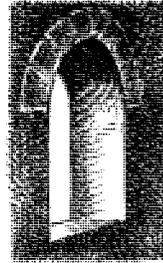
протяжённость (вдоль лицевой поверхности) перекрываемого пространства. 2. Проезд с криволинейной перемышкой. 3. Дугообразная вставка посреди кладки, перераспределяющая нагрузку на основание (=разгрузочная арка).
