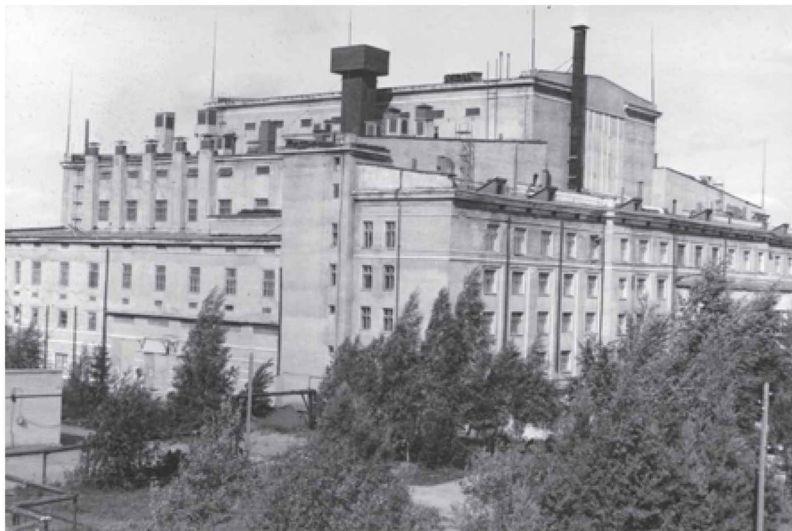
Цех № 1 с установкой СУ-20
