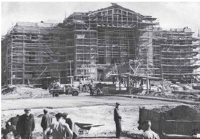
Строительство дома культуры
