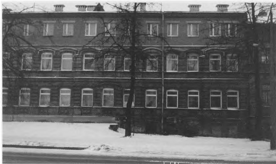
«Каменный дом Канатчикова» (напротив Борисо-Глебского собора), в котором А. А. Добычина снимала квартиру во второй половине 1900-х — начале 1910-х гг. (третий этаж надстроен позже). Декабрь 1998 г. Фото А. Ю. Арьева.
