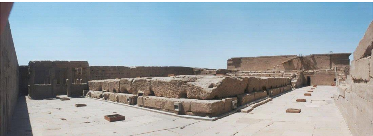
Рис. 1.11. Вид крыши с юго-восточного угла [16], http://chronologia.org/egypt/images/dendra-roof_t.jpg
