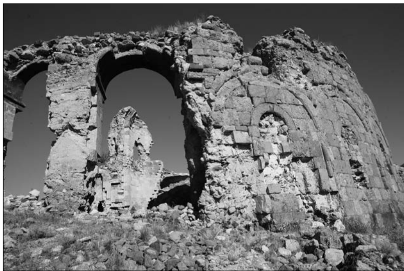
Рис. 2. Бана. Облицовка X в. поверх фасада VII в. Фото автора
